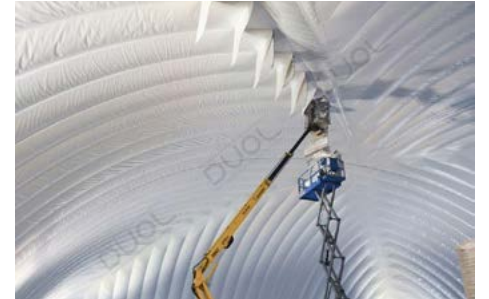
DF Ultra Yalıtım Sistem montajı
